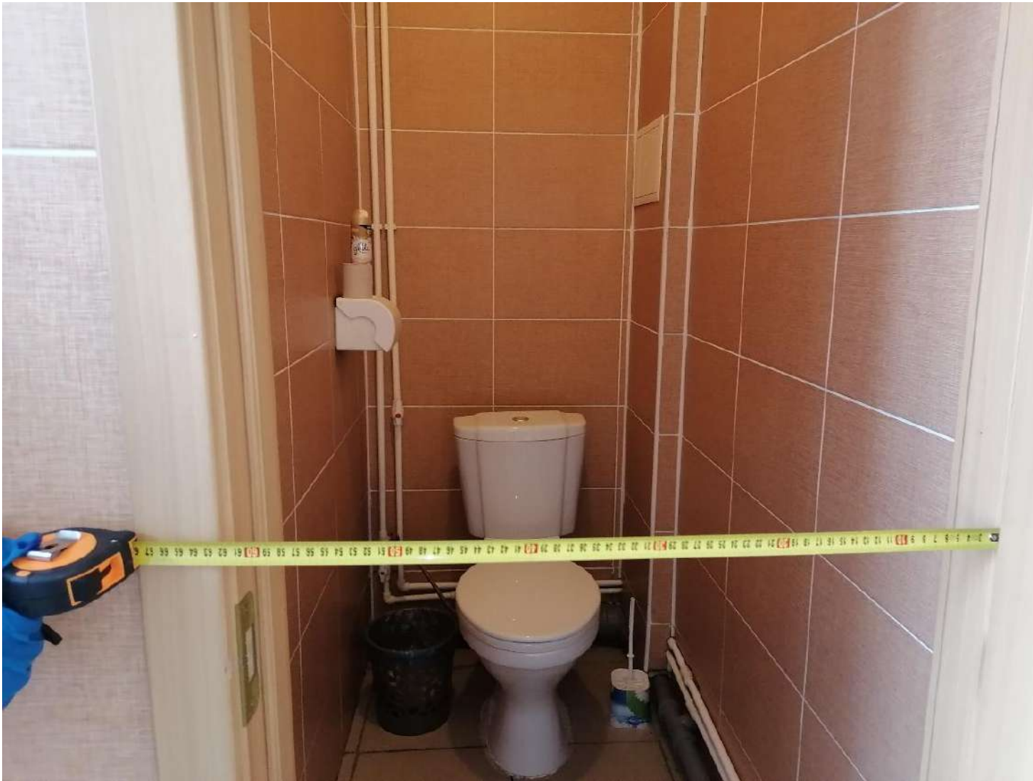
Фото № 20 Дверь в санитарно-гигиеническое помещение
