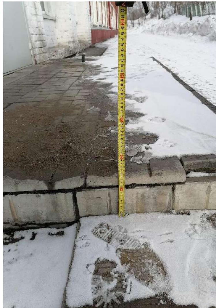
Фото № 10 Высота ступеней крыльца
