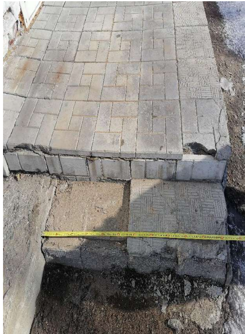
Фото № 8 Ширина ступеней крыльца
