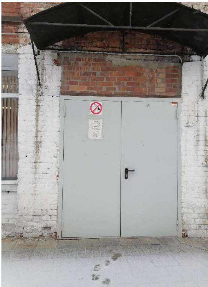
Фото № 11 Вход в здание
